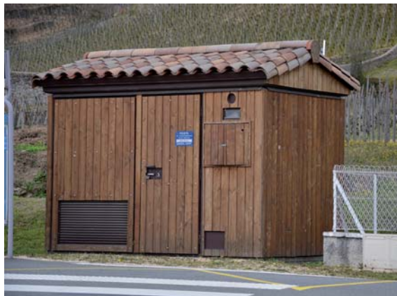
Exemple de local pour transformateur électrique
