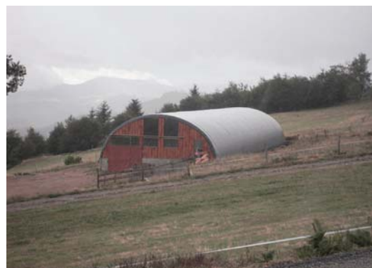
Exemple de tunnel agricole de teinte grise
