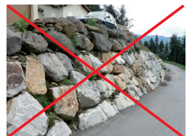
Exemple d'enrochements de type cyclopéen
