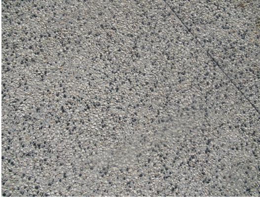
Béton désactivé utilisé lors de la 1<sup>ère</sup> phase de travaux
